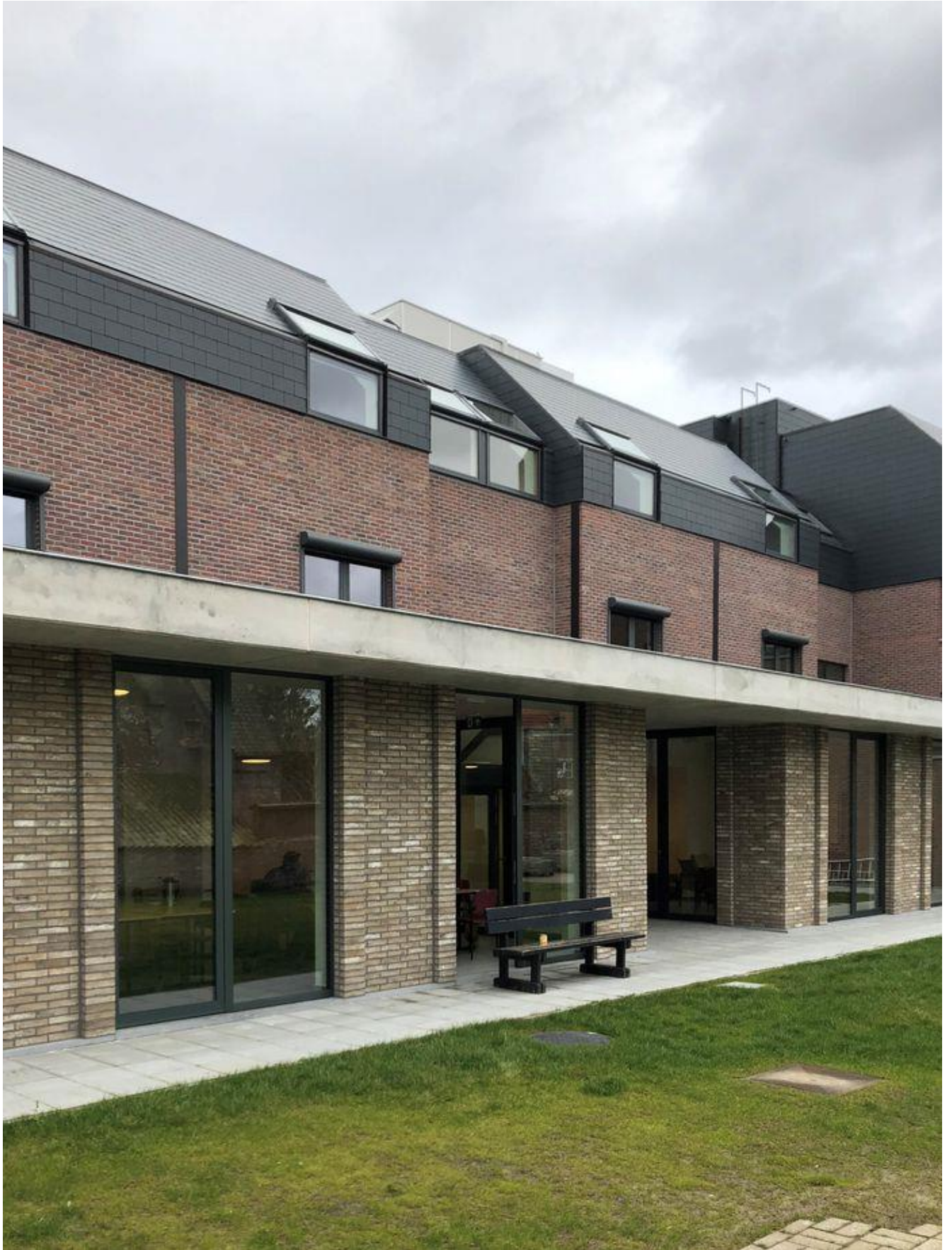
Het gerenoveerde gebouw beschikt ook over een stadstuin. © Geert De Rycke
